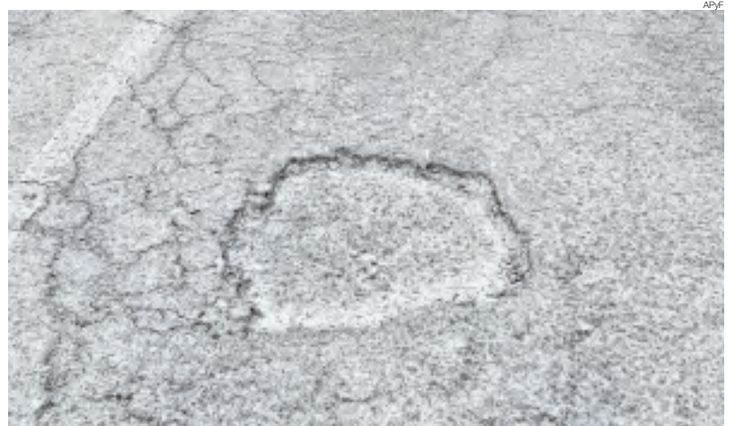
▶▶ Estado actual de la carretera de Aliseda.
